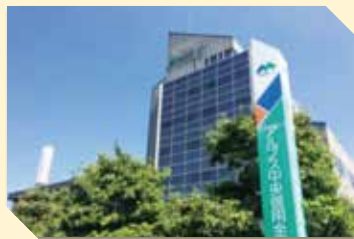
アルプス中央信用金庫新館 西側より撮影
